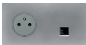
Prise 2P+T et prise RJ45
