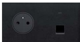
Prise 2P+T et prise RJ45
