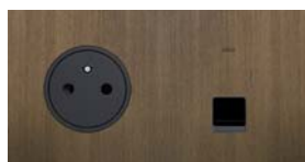
Prise 2P+T et prise RJ45
